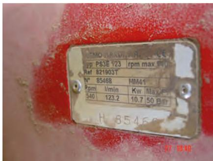
*Medida del caudal nominal de la bomba según las especificaciones del fabricante. Método opcional de comprobación del funcionamiento de la bomba*
