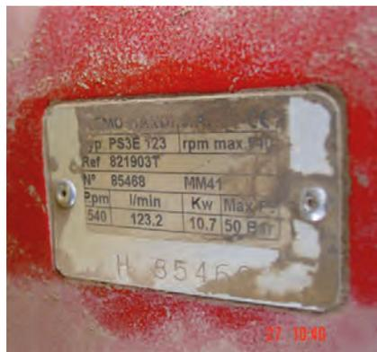
*Medida del caudal nominal de la bomba según las especificaciones del fabricante.
